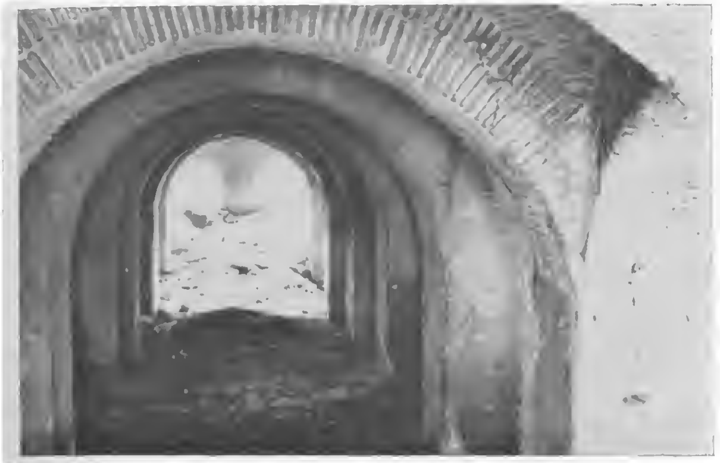
FIG. 9. — L'intérieur de la citerne, vue vers l'ouest.
